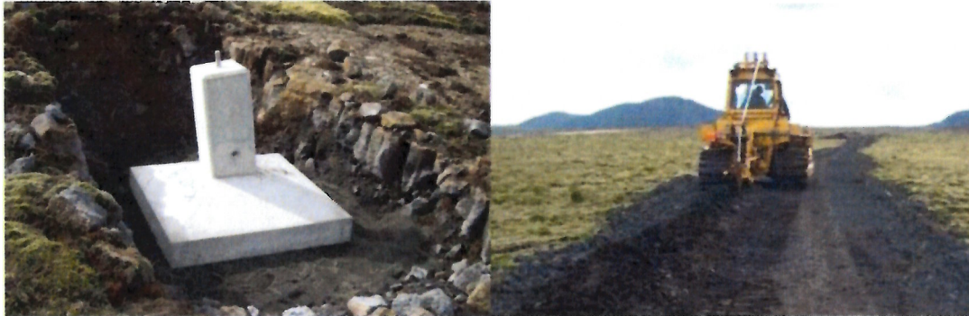
Mynd 4 Dæmigerð mynd af undirstöðu undir burðarmastur áður en fyllt er að henni og til hægri sést hvernig jarðskaut er plægt í vegslóð. Vegslóðin á myndinni er nokkuð dæmigerð.
