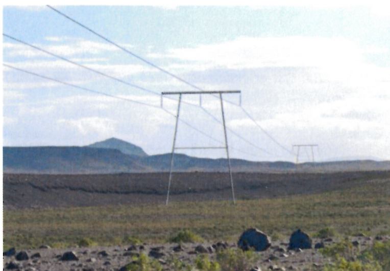
Mynd 2 Burðarmöstur í KR4 með og án jarðvírseyra á efri mynd.
